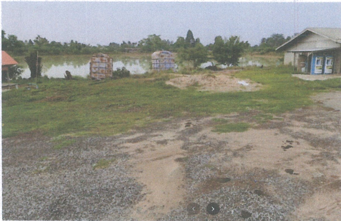
ภาพสถานที่ ดำเนินโครงการก่อสร้างระบบประปาหมู่บ้านแบบผิวดินขนาดใหญ่มาก ตามแบบมาตรฐานกรมทรัพยากรน้ำ บ้านสระขาม หมู่ที่ ๑
